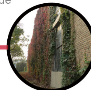
厂房外部 Plant external
