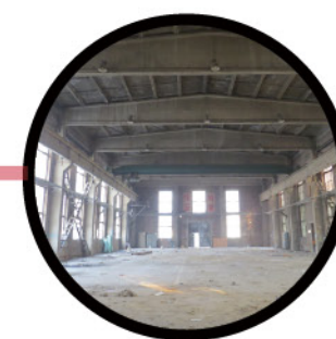
厂房内部 Plant inside
